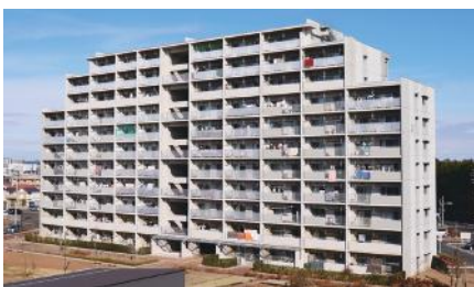
【施工実績】災害公営住宅「荒井東市営住宅」（仙台市若林区）
