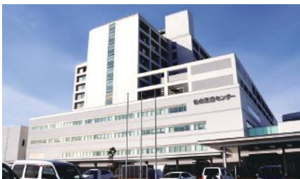
【施工実績】仙台医療センター（仙台市宮城野区）
